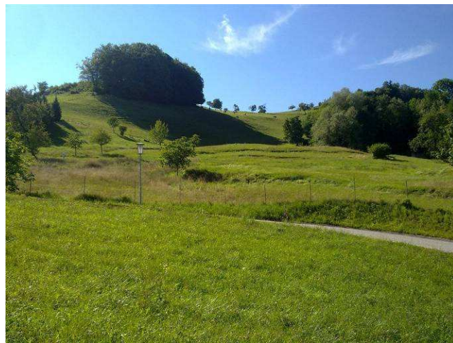
Rutschung in Gresten, Betonpfeiler als Messpunkte
